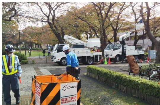
光回線ケーブル工事
