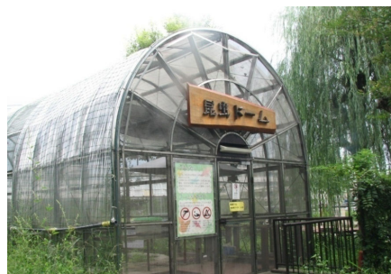
図1 昆虫ドームの外観
