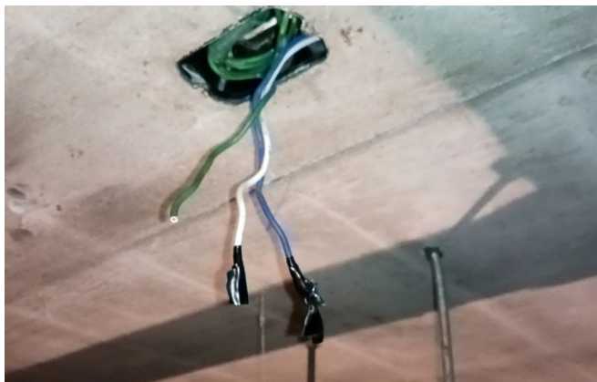
配線の修理・取り替え
